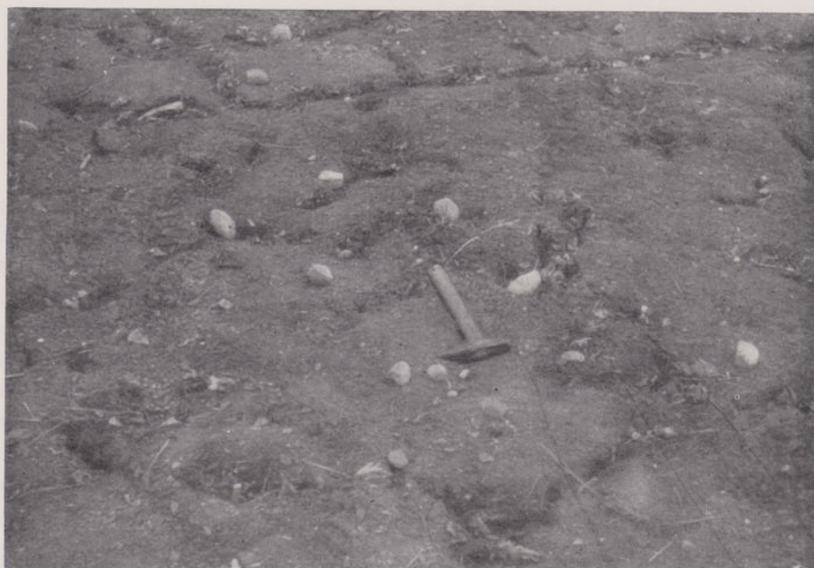
Fig. 2 — Pormenor do solo fendilhado e do calibre do material do terraço
