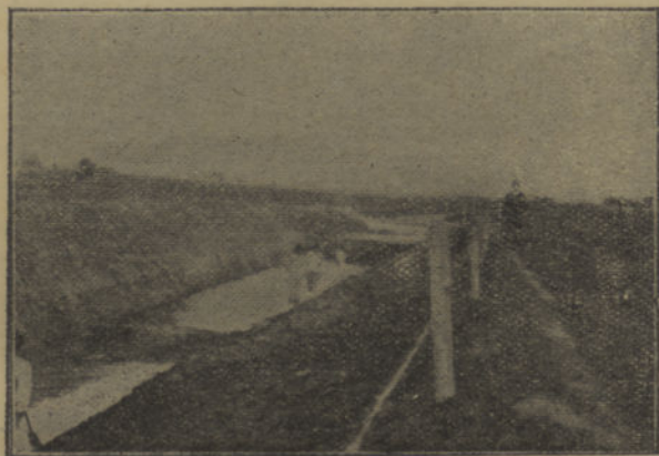
A vala de S. Bento de Benavente durante os trabalhos de bonificação.
