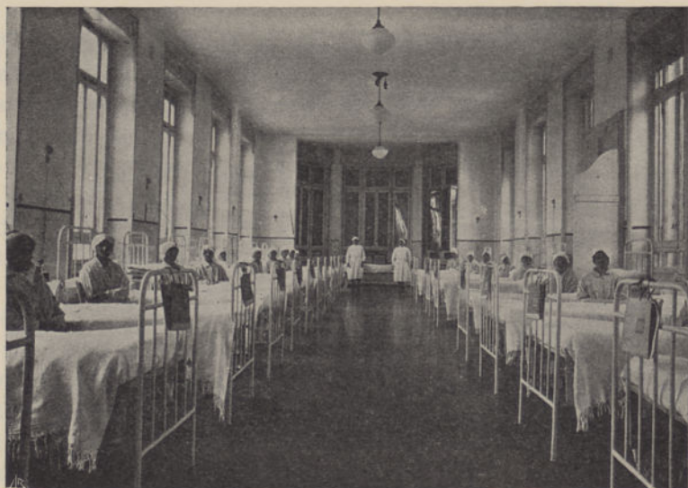
INSTITUTO DO CANCRO DE MILÃO — Enfermaria
