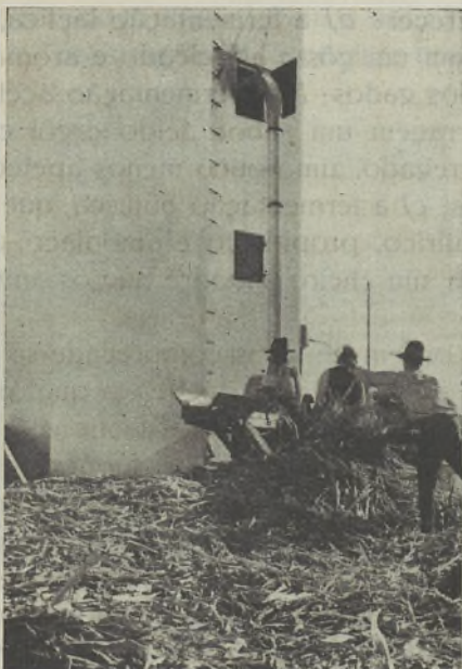
FIG. 11—Vista da calha de alimentação e tubo de elevação
