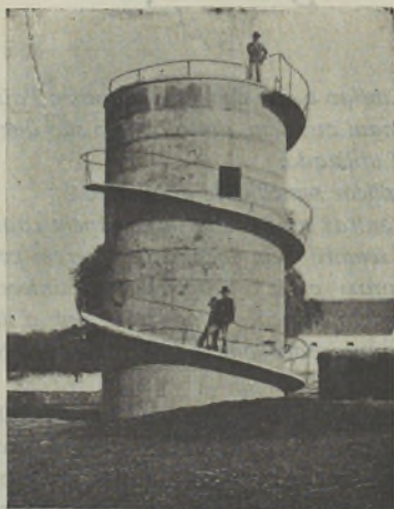
FIG. 1—Silo de cimento armado com escada de caracol—luxo dispensável. Herdade do Facho do Sr. Dr. José Pulido
