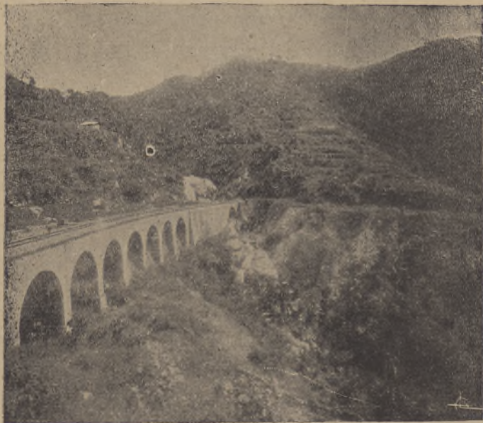
Fig. 301 — Caminho de ferro de Mormugão : um viaduto mostrando a aciditação do solo.
