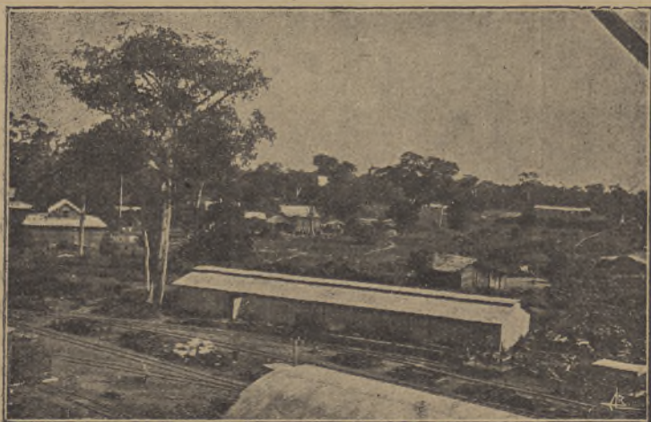
Fig. 272 — Grande centro industrial do açúcar de cana — a Vila Fontes de Sena-Sugar. Linha do caminho de ferro da companhia.
