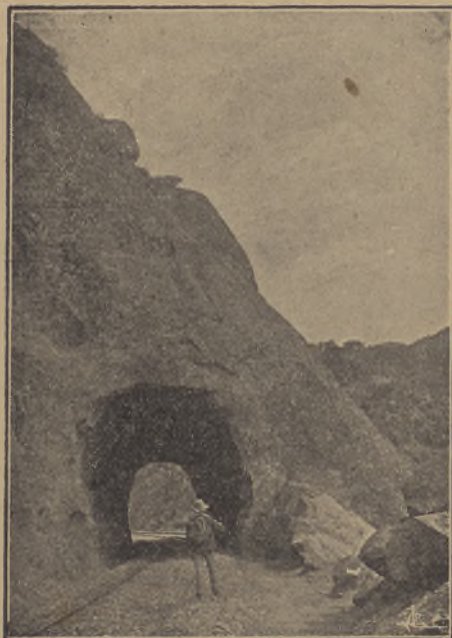
Fig. 91 — Túnel de Pôrto-Rei. (Fotografia de Marçal Brandão).
