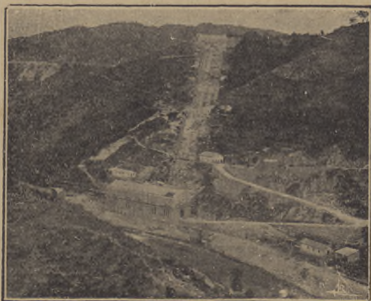
Fig. 87 — Queda de água do Lindoso, precipitando-se sobre o Lima, de 186 m. de altura. As águas percorrem 6 km. de canais e 4 de túneis até ao ponto donde se precipitam, fornecendo 40 mil cavalos de energia no inverno e 10 mil na estiagem.
