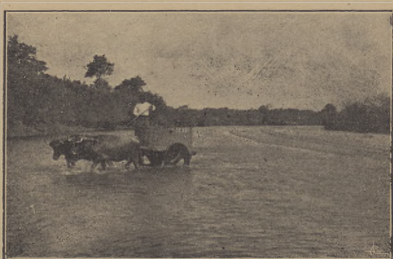
Fig. 40 — Num meandro do Vouga. Passagem a vau.
