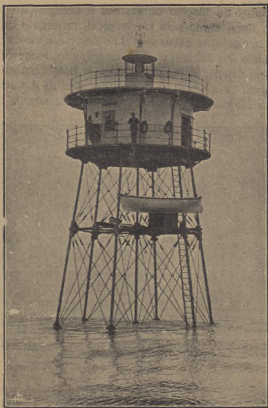
Fig. 243 — Farol de Cockburn. Construção de aço, assente em estacas de hélice, no baixo denominado de «Cockburn», considerado como o cemitério dos navios que demandavam a baía de Lourenço Marques. O farol está a 30 qm. de terra, em pleno Oceano, e a sonda acusa 7 m ,3 na baixa-mar e 11 m ,3 na praia-mar, sobre uma região extremamente exposta aos temporais que com rapidez e impetuosidade se levantam na costa oriental da África. A construção representa uma verdadeira obra-prima e uma glória para a engenharia portuguesa, pois que de 6 tentativas para o levantamento do farol, só os estudos, decisão e energia do engenheiro-militar José Maria de Vasconcelos e Sá, conseguiram vencer a violência das ondas, inaugurando o notável farol em janeiro de 1901. As 6 tentativas frustradas foram realizadas por engenheiros franceses e ingleses.
