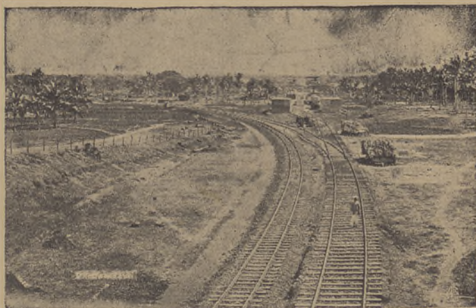
Fig. 300 — Caminho de ferro de Mormugão, junto ao pôrto.
