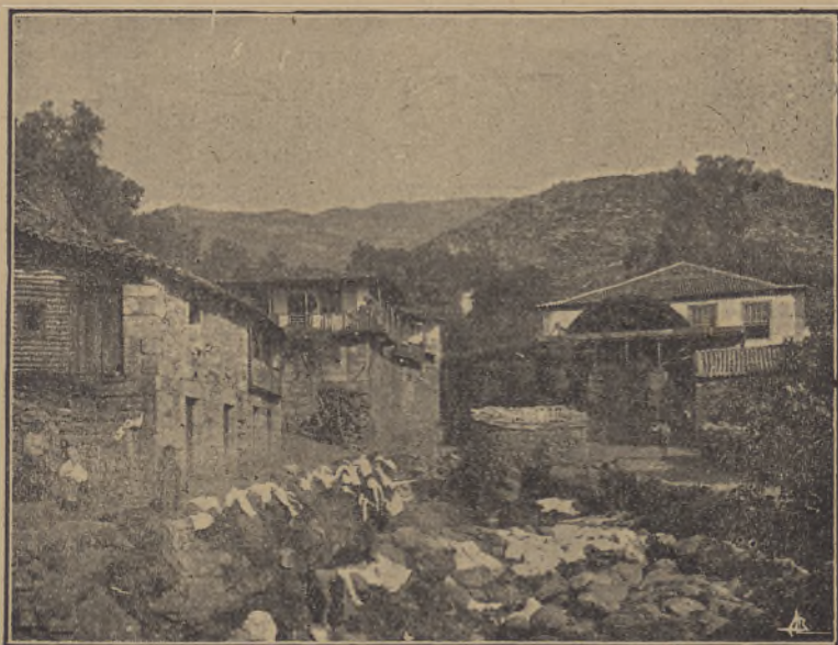
Fig. 88 — Fábrica de lanifícios em Unhais da Serra, Beira-Baixa. Durante o princípio e meados do século XIX, a indústria portuguesa foi subsidiária das pequenas quedas de água que lhe moviam os seus engenhos privativos. Hoje as grandes indústrias voltam a servir-se das quedas de água, usando, porém, processos muito mais aperfeiçoados e cómodos.
