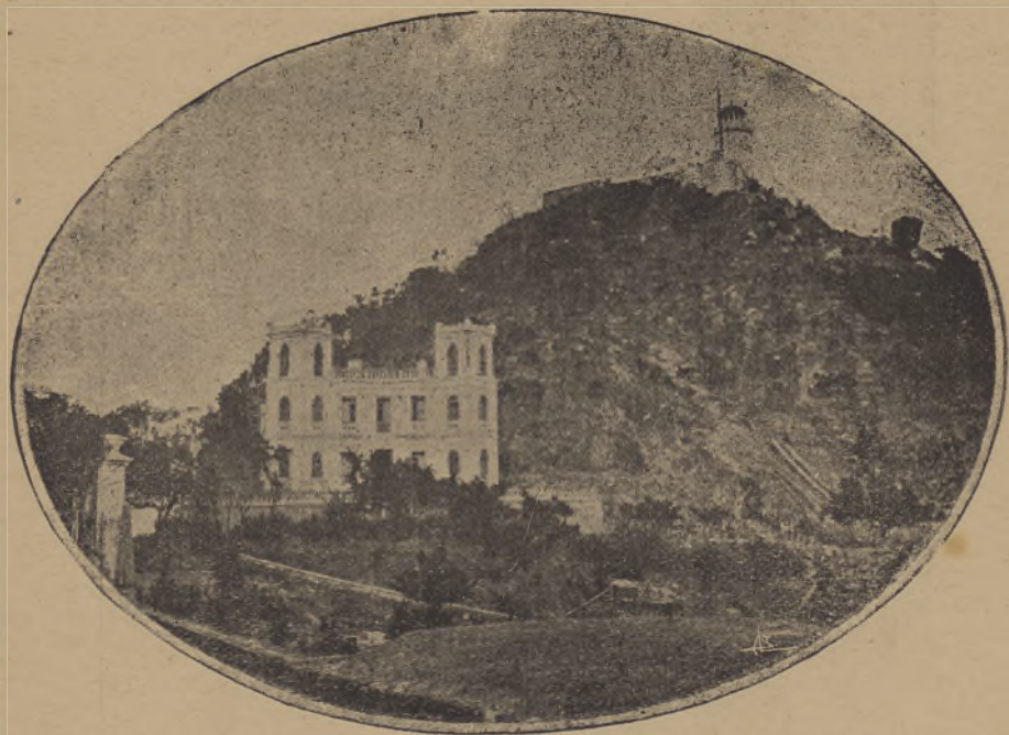
Fig. 309 — Farol da Guia. O 1.º farol edificado sobre águas chinesas.
