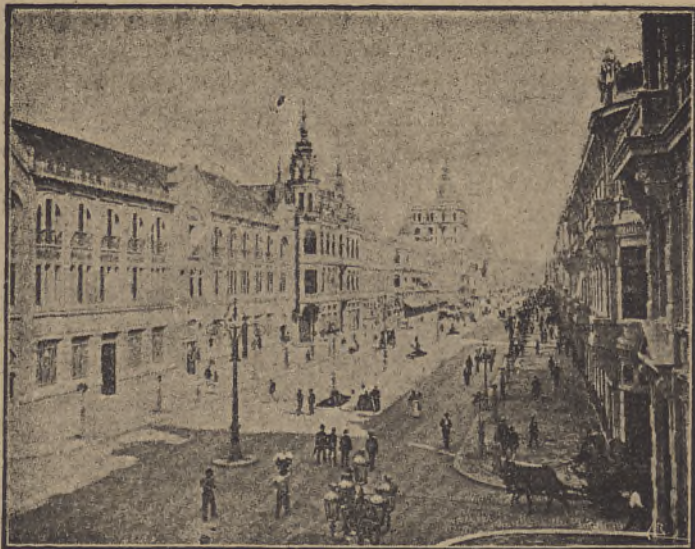
Fig. 368 — Rio de Janeiro. Avenida Central.
