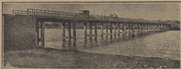
Fig. 279 — Ponte de cimento armado na estrada de Lourenço Marques a Goba.
