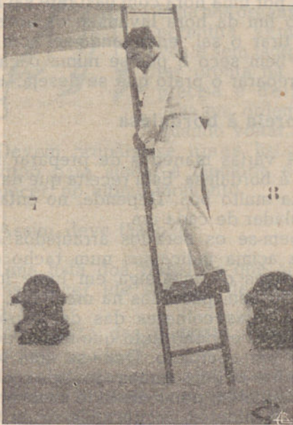
Uma escada mal colocada
