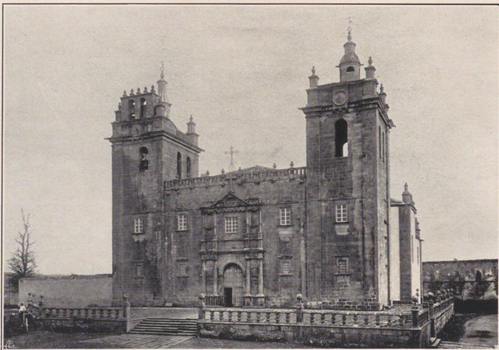
Fig. 5 — MIRANDA DO DOURO — Sé Catedral — Mandada construir por D. João III — Inaugurado o lançamento da primeira pedra em 24 de Maio de 1552. Belo templo de três naves. Mede da porta da entrada ao Cruzeiro 23\text{m},30 tendo de comprimento total 48\text{m},90 . A largura na altura do Cruzeiro é de 40\text{m},30 . Este templo possui um adro muito espaçoso todo em granito. O cabido da Sé de Miranda prestou, à defesa nacional, relevantes serviços ajudando monetariamente a levantar fortificações, muralhas, baluartes, etc.
