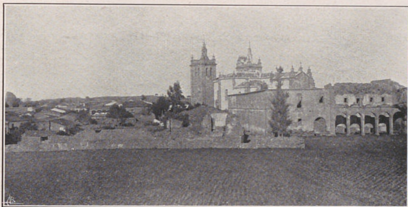
MIRANDA DO DOURO — Actual sede de Comarca de 3. a classe, concelho de 4. a ordem!... (Vista geral)
