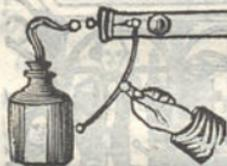
Póde-se com a descarga electrica produzir a dilatação do ar de um cano de espingarda (fig. 82.<sup>a</sup>) e disparar uma bala
