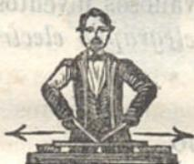
da por tres processos: por *toque singello*, correndo com uma unica barrinha magnetica (fig. 100.<sup>a</sup>) a porção de aço ou ferro que se quer magnetizar; por *toque dobrado*, correndo (fig. 101.<sup>a</sup>) com duas barrinhas o ferro, do meio d'elle para os extremos; e por *toque conjuncto*, quando, em vez de uma ou duas barrinhas, se
