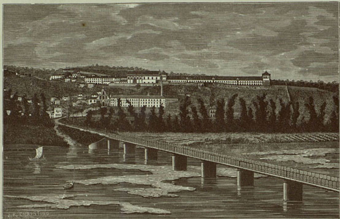
Nova ponte de ferro sobre o Mondego em frente de Coimbra
