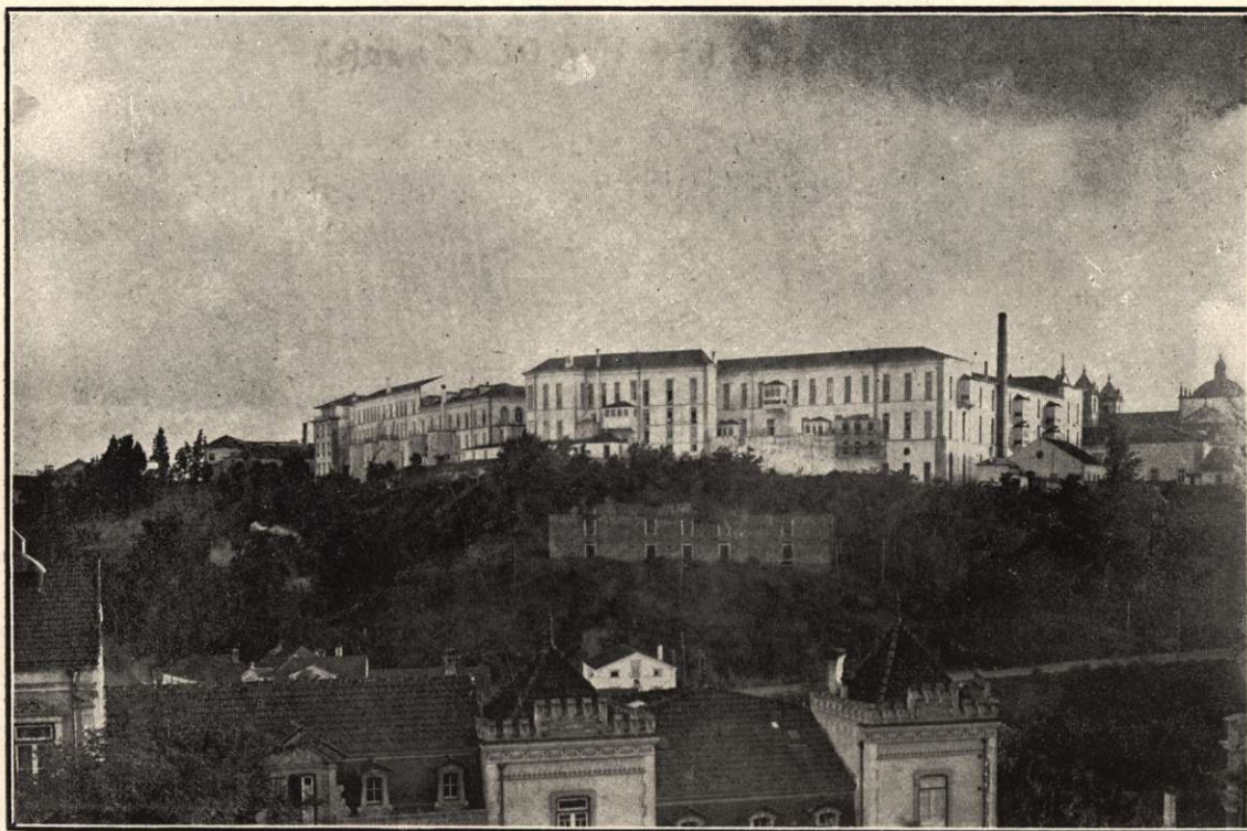
H. U. C. — EDIFÍCIO VISTO DO BAIRRO DE SANTA CRUZ. NA CÊRCA EM CONSTRUÇÃO, A PARTE DESTINADA AO ECONOMATO, ROUPARIA, LAVANDARIA E FARMÁCIA
