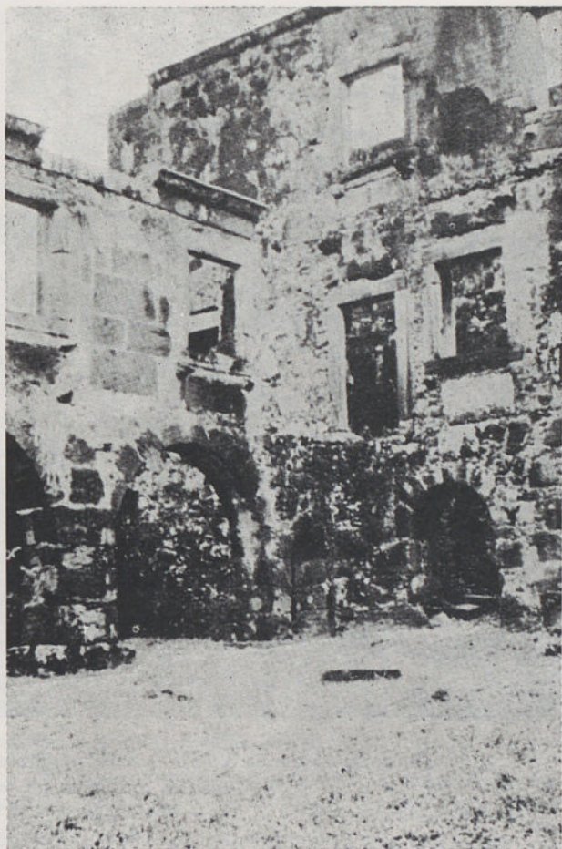
Tatuapara (Mata de S. João — Baía). Aspecto parcial do sector da Torre de Garcia d'Ávila que foi construído no primeiro quartel do século XVIII.
