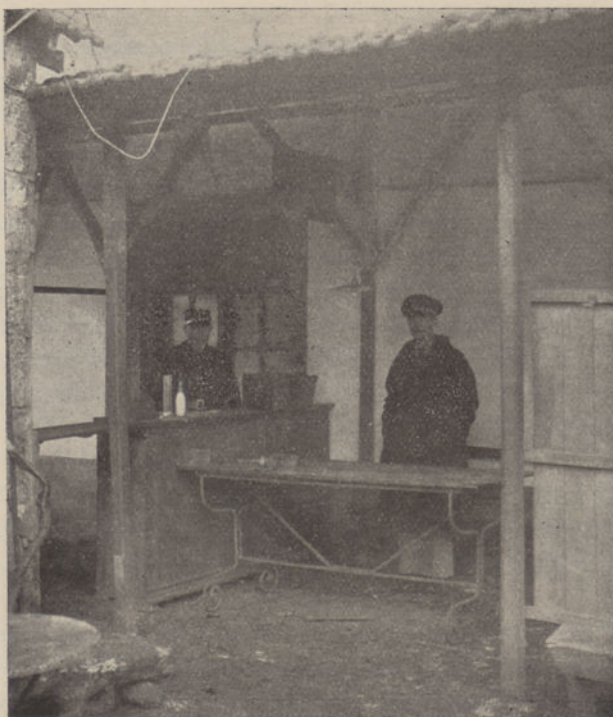
Fig. 2 — Pôsto de fiscalização policial do Calhabé (vista interior)
