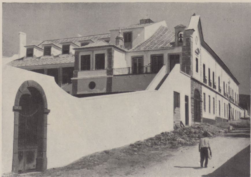
Hospital da Quinta da Flamenga
