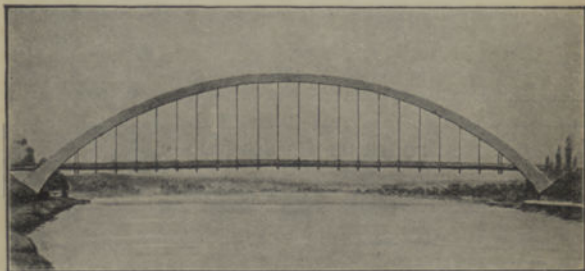
PONTE DE SAINT-PIERRE-DU-VAUVRAY Tipo de ponte em arco de cimento armado.
