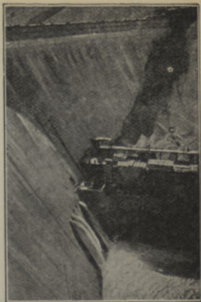
BARRAGEM BOISE (Idaho) (ESTADOS-UNIDOS)
