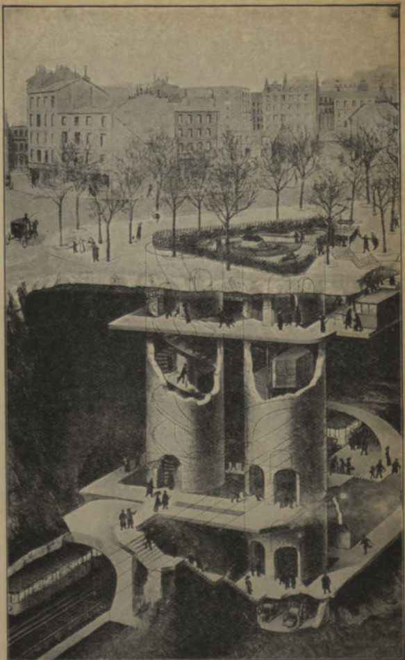
A ESTAÇÃO DO CAMINHO DE FERRO NORTE-SUL SOB A PRAÇA DAS ABBESSES
