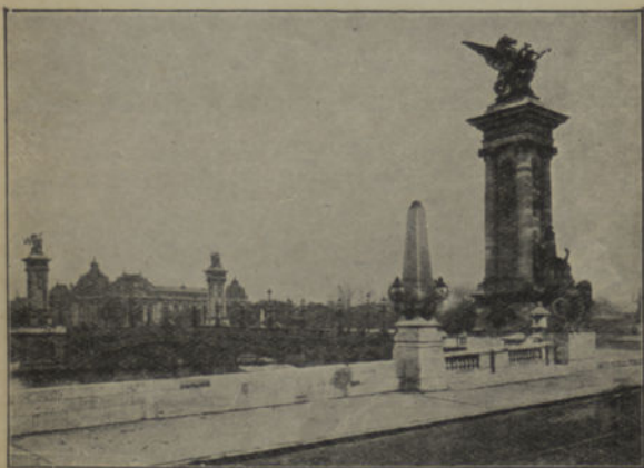
PONTE ALEXANDRE III Tipo de ponte metálica de arco de volta muito abatida
