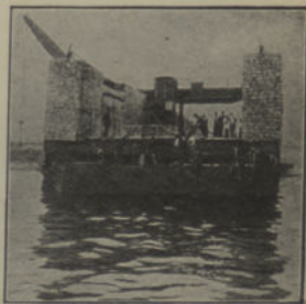
Enscadeira metálica para a construção dos caixões.
