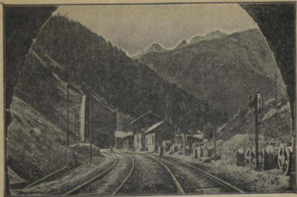
O TÚNEL DO MONTE-CENIS
