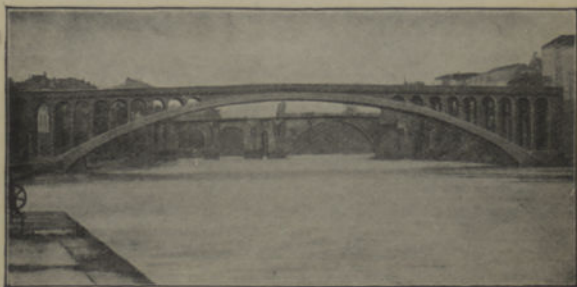
PONTE DE VILLENEUVE-SUR-LOT Tipo de ponte em arco de cimento não armado.
