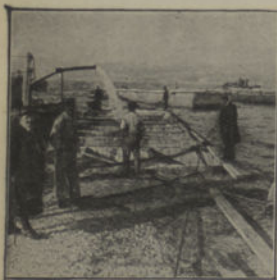
Mergulhamento dum caixão por enchimento de água.
