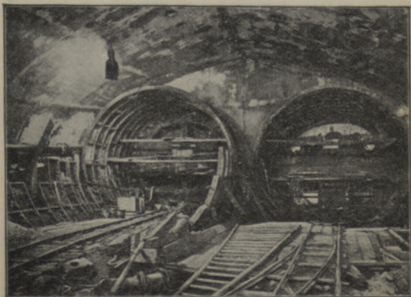
A ENTRADA DOS DOIS TÚNEIS CIRCULARES PARA A TRAVESSIA DO SENA PELO CAMINHO DE FERRO DO NORTE-SUL
