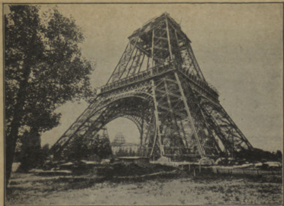
A TÔRRE EIFFEL EM CONSTRUÇÃO
