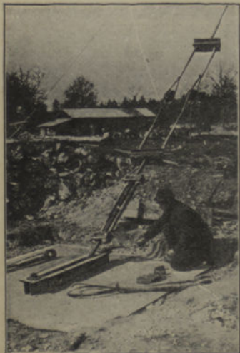
AMARRAÇÃO DUMA ESPIA AO SEU MACIÇO DE BETÃO
