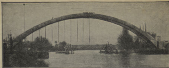
PONTE DE SAINT-PIERRE-DU-VAUVRAY Arco depois do descimbramento.
