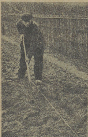
Marcada com uma corda, a linha no terreno, abra-se, à enxada, uma valeira de 50 cm. de largura e com a profundidade de 15 a 20 cm., deitando a terra para os dous lados
