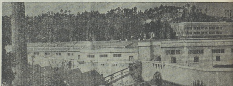
Fig. 40 — Aspecto geral da Fábrica
