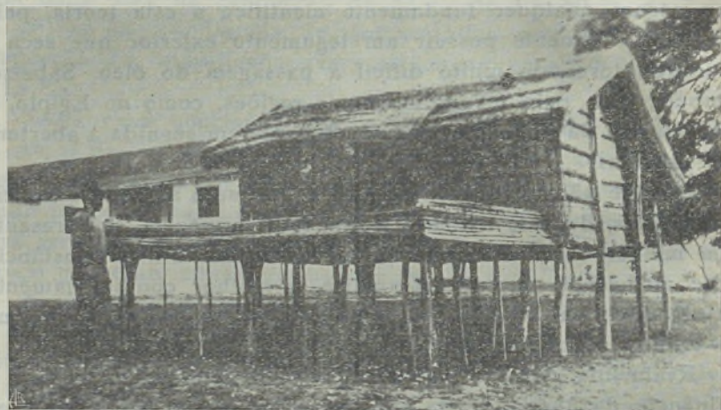
Fig. 21—Tipo primitivo de secadores, feitos com bambus, que são adoptados com óptimo resultado, nas zonas da Companhia Nacional Algodoeira, em Manica e Sofala, Moçambique
