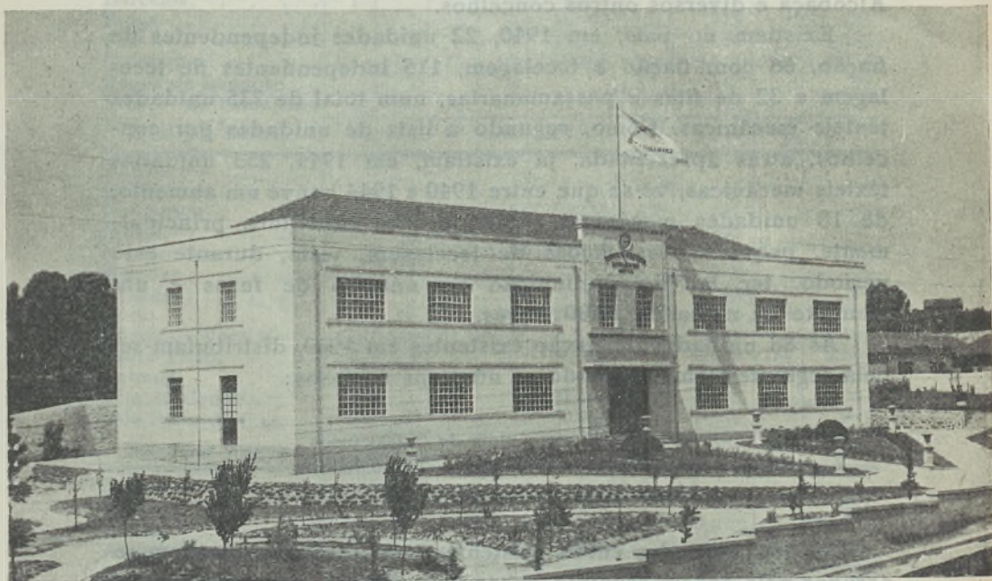
Fig. 37 — Pavilhão de assistência da Empresa Industrial de Santo Tirso
