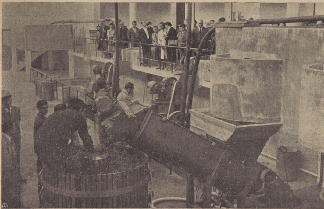
Adega Cooperativa do Marco de Canaveses — secção de esmagamento, esgotadores estáticos dos bagaços de uva branca, vendo-se em primeiro plano um esgotador helicoidal a 45°
